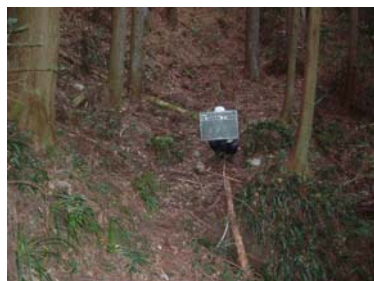
作業歩道開設
