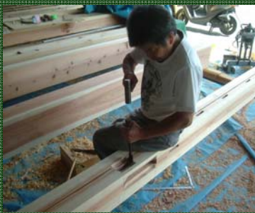
写真は5寸角の杉材(森町産)を刻む。機械に頼りきらず、匠の技を随所に生かす。
