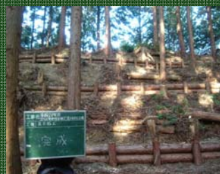
現地発生材を利用した 丸太筋工 治山事業
