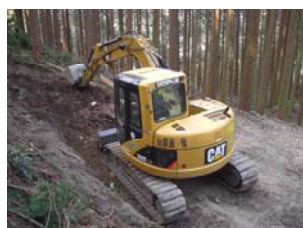
低コストで間伐材を搬出しやすい作業道を開設
