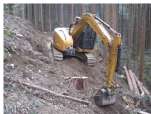
低コストで間伐材を搬出しやすい作業道を開設
